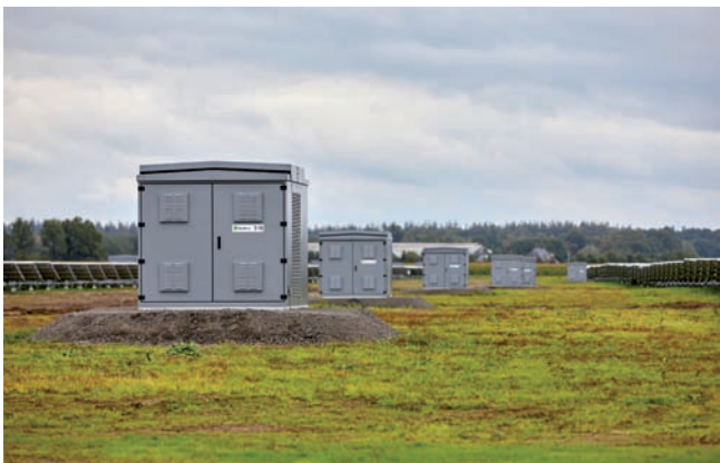
Obr. 2 Pri sieťovom prepojení jednotlivých transformačných staníc inštalovaných na zemi bolo potrebné zvážiť rôzne špecifiká.
