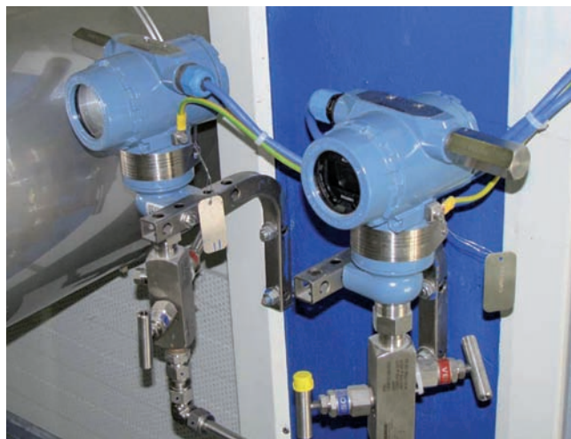
Obr. 6 Ochrana tlakomera v prostredí Ex vodičom prepätia DEHNpipe konštrukčne vyvinutá na montáž priamo na tlakomer od výrobcu DEHN SE + Co KG.
