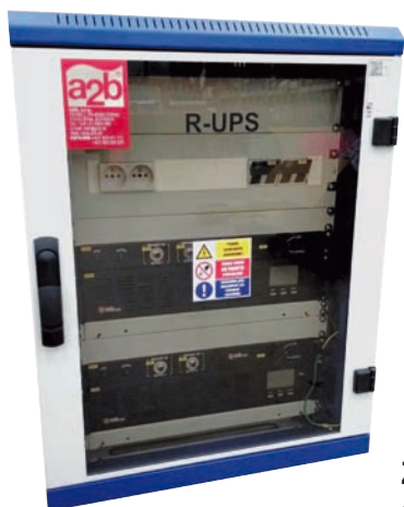
Kabinet s dvoma UPS 19", s bajpasom a zásuvkami na napájanie záťaží
