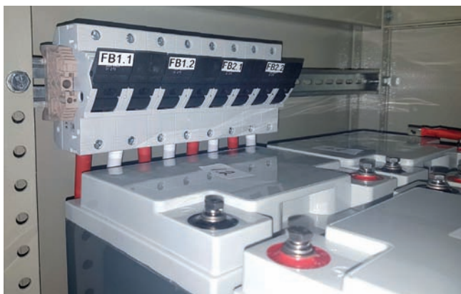
Batérie v kabinete s batériovými odpojovacími
