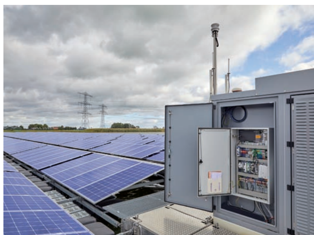
Obr. 6 Na trafostanici sú inštalované všesmerové antény.
