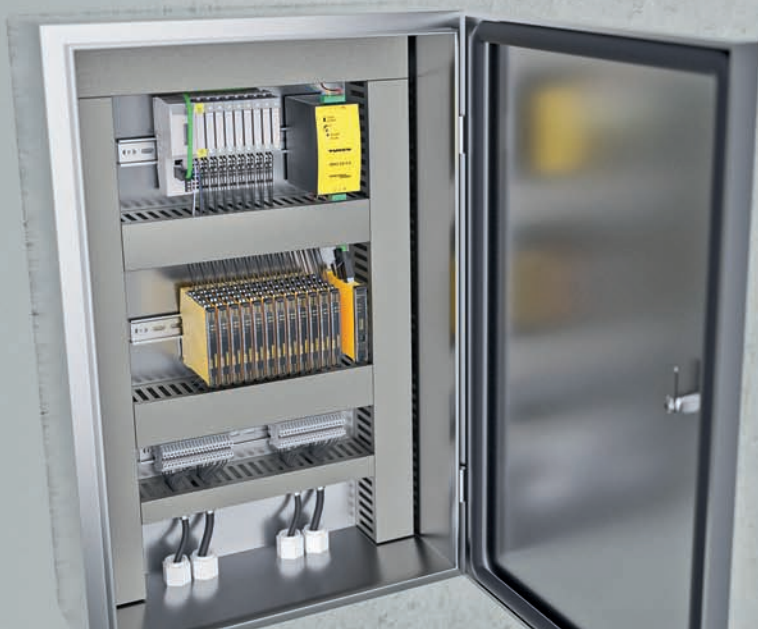
Údaje týkajúce sa stavu rozvádzača umožňujú používateľom predchádzať poruchám a zvyšovať tak dostupnosť ich zariadenia.
